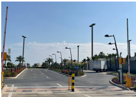
BENITO installe 126 ensembles lumineux autour d'un hôtel à Doha.
