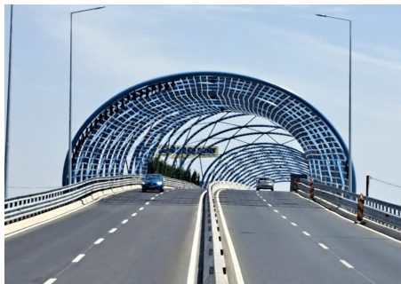
Luminarie per il Bridge Pallady Boulevard di Bucarest, Romania
